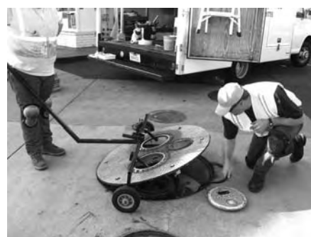
直上型の注油口の検査
