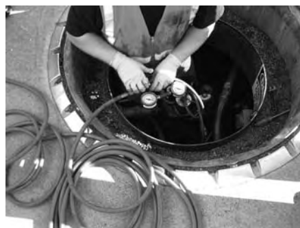
埋設配管の点検
