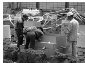
配管等を埋設する前に、消防署の検査を受ける。
