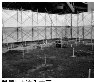
次に、ポンプを使用してフェントン反応剤（鉄の溶液、過酸化水素）を井戸から地中に注入します。
